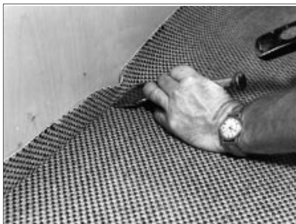
Abbildung 8 Den Teppich mit dem Treppeneisen in den Boden-Wandwinkel drücken.
