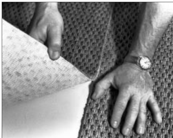
Abbildung 5 Weitere Bahnen 1 - 2 Fäden überlappen
