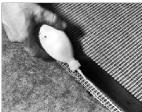
Abbildung 13 Ruckstuhl-Nahtkleber beim linearen Auftrag mit Schiene äusserst sparsam auftragen
