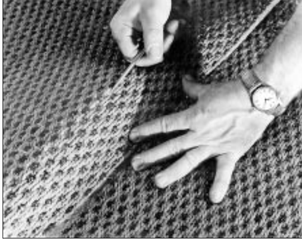
Abbildung 7 Die überlappende Bahn stossen
