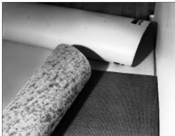
Abbildung 3 Bahnen quer zur Unterlage verkleben
