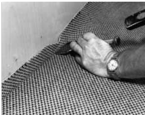
8) Presser le tapis dans l'angle sol-paroi avec le fer à escalier
